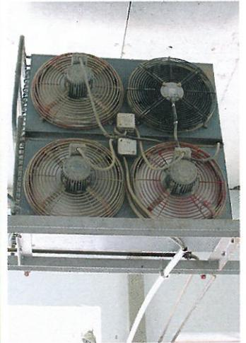
Kühlaggregate brauchen innerhalb von Gebäuden mehr Strom.
