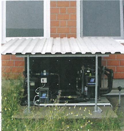
Wird das Kühlaggregat draußen montiert, spart man 2 bis 3 % an Energie ein.
