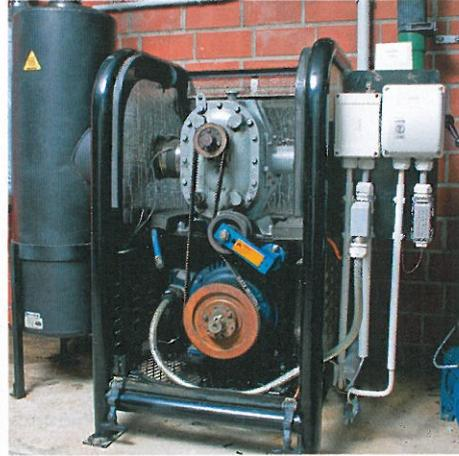
Frequenzgesteuerte Vakuumpumpen brauchen bis zu 60 % weniger Energie.
